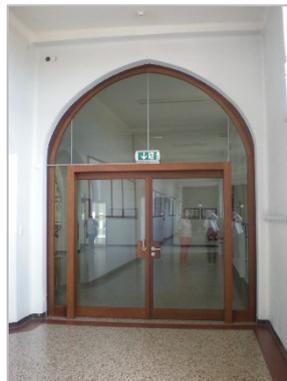
Abbildung 10: Durchgänge (jetzt versehen mit Feuerschutztüren) in neogotischen Spitzbögen
