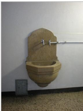
Abbildung 9: Handwaschbecken zur Trinkwasserentnahme aus Juramarmor im Haupttreppenhaus
